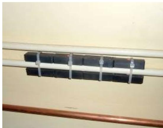
Huit aimants appliqués deux par deux en attirance de part et d'autre du tube d'arrivée d'eau de la ville, et en prenant soin d'alterner chaque groupe de deux aimants, un groupe face nord d'un côté et le suivant face nord du côté opposé, et ainsi de suite pour les quatre groupes de deux aimants, ils suppriment une très grosse part de dépôt de calcaire. Cela existe déjà mais là c'est beaucoup plus économique.
